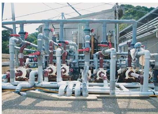
取水系統は合計8系統あり、沖の海底からポンプアップして揚水している。最大約8000 t / 日の揚水量に対してUV殺菌システム 9台を使用し、その後70 t 程度の調整槽へ流入している。
