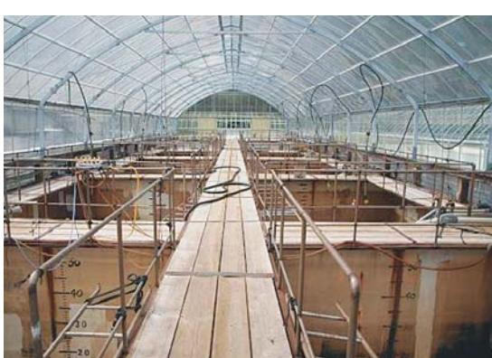
ワムシ培養棟には容量55 t の水槽が計12面ある。隣接するスレート式の建屋には温調機やワムシわくわくを設置し、ワムシ増殖の安定化を図っている。水槽は1次培養と2次培養で使い分けしており、水槽環境を調節するための設備が両者で異なる。稚魚水槽へのワムシ供給は2次強化槽からの抜き取りや洗浄、分配まで自動システムによって行っている。また、収穫後のワムシは洗浄水とともにUV管を通すことで殺菌している。その際、ワムシへのUV照射量を一定にするため、流量・流速をバルブによって調整している。
