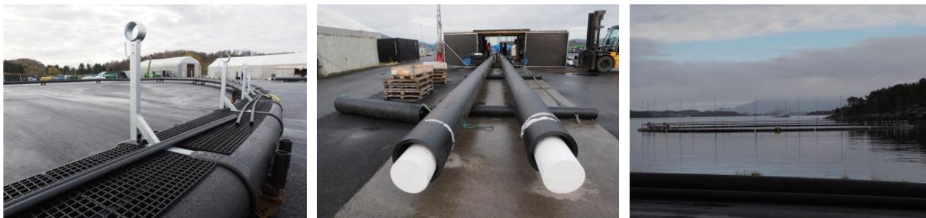
写真5 (左から) 完成間近のいけす枠、パイプの圧着作業、海上での曳航
