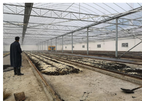
レールを用いた大量養殖場
